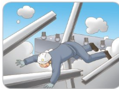
● 부재 접합부 체결 불량으로 철골 부재 무너짐
